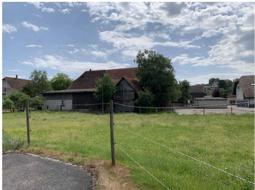
Abbildung 7 Sicht auf den kantonal geschützten Speicher (eigene Aufnahme)
