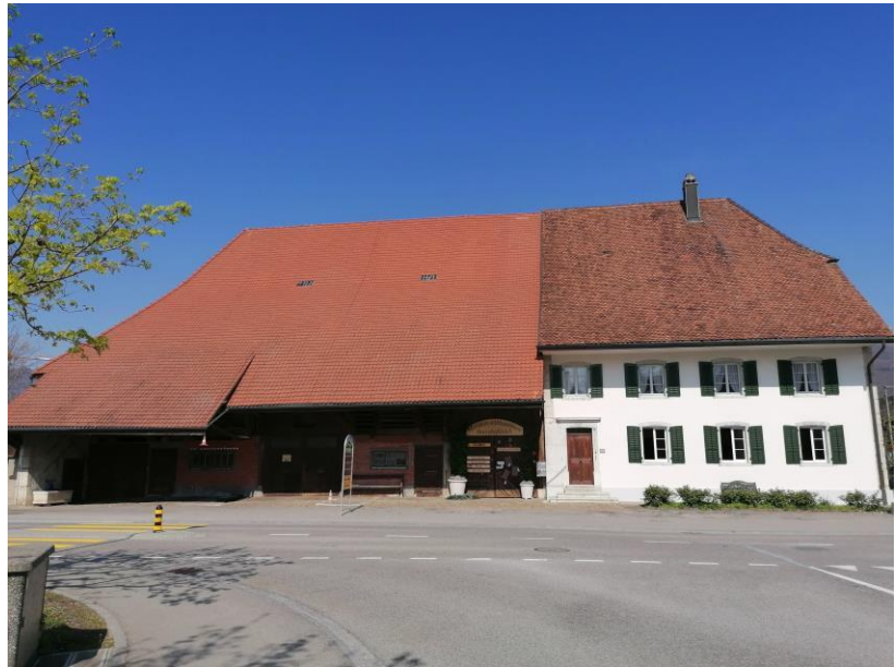
Abbildung 6 Sicht auf das kantonal geschützte Bauernhaus (eigene Aufnahme)
