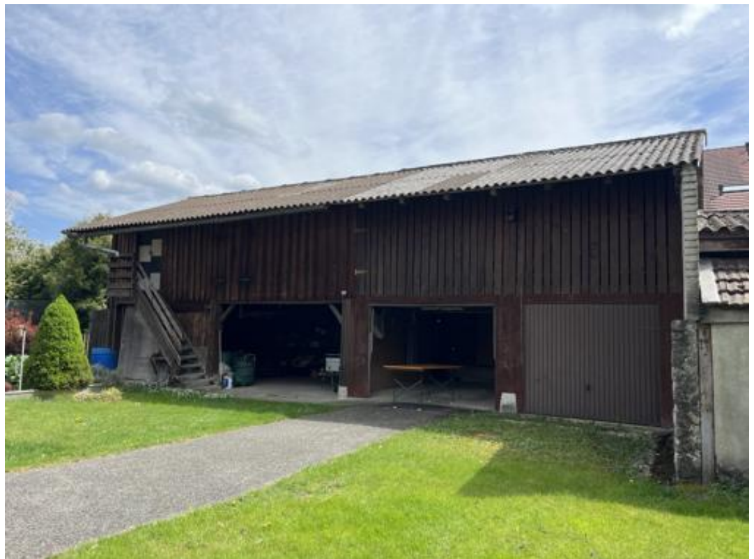
Abbildung 5: Nebenbaute, Gäustrasse 2a
