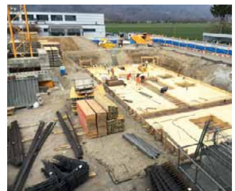
Der Kellerboden wird betoniert.
