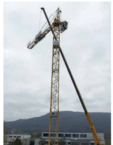
Der grosse Kran stellt den noch viel grösseren Kran auf.
