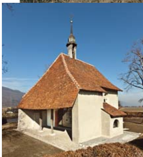
Kapelle nach der Renovation
